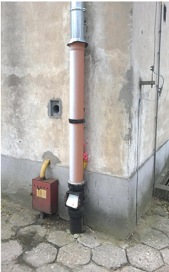
Narożnik pół-wsch. Widoczna rura spustowa, skrzynka gazowa, inst. odgromowa i oświetl. zewnętrzne oraz kratki wentylacyjne.
