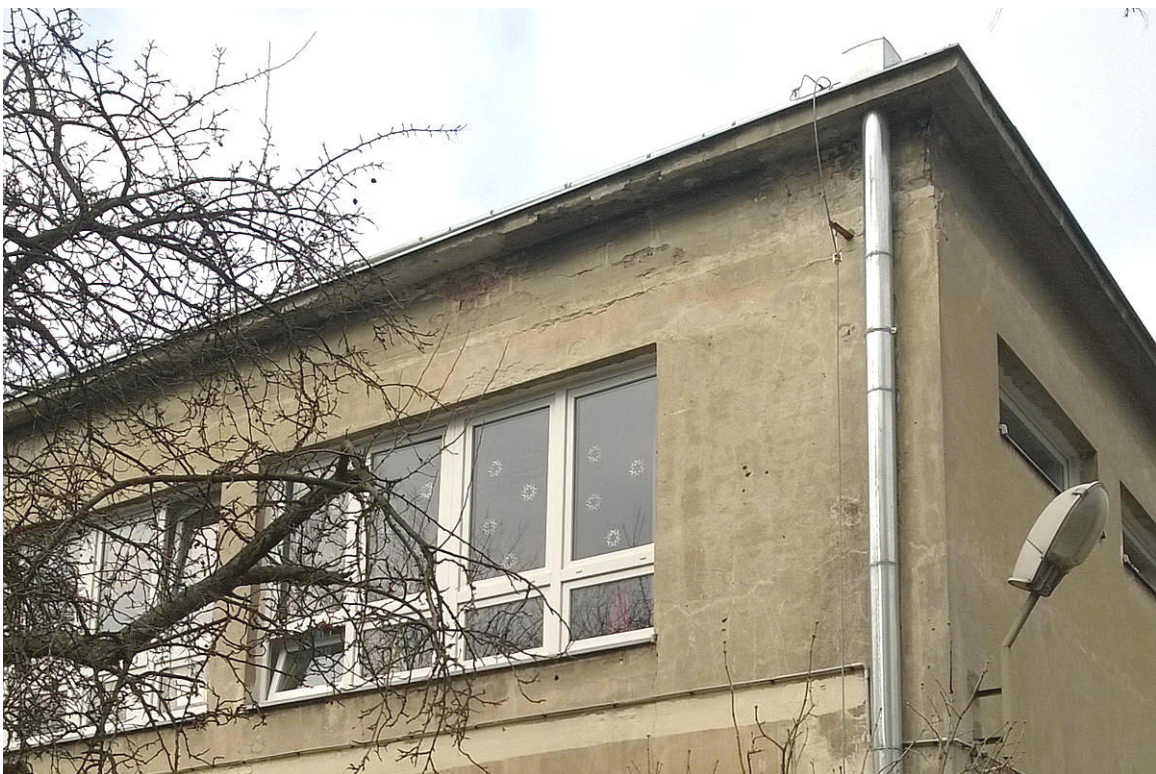
Uszkodzenia tynku na ścianie stropodachu oraz gzymsie – narożnik pół-wsch.
