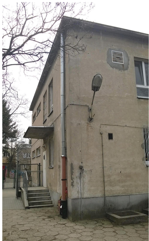
Narożnik pół-wsch. Widoczna rura spustowa, skrzynka gazowa, inst. odgromowa i oświetl. zewnętrzne oraz kratki wentylacyjne.
